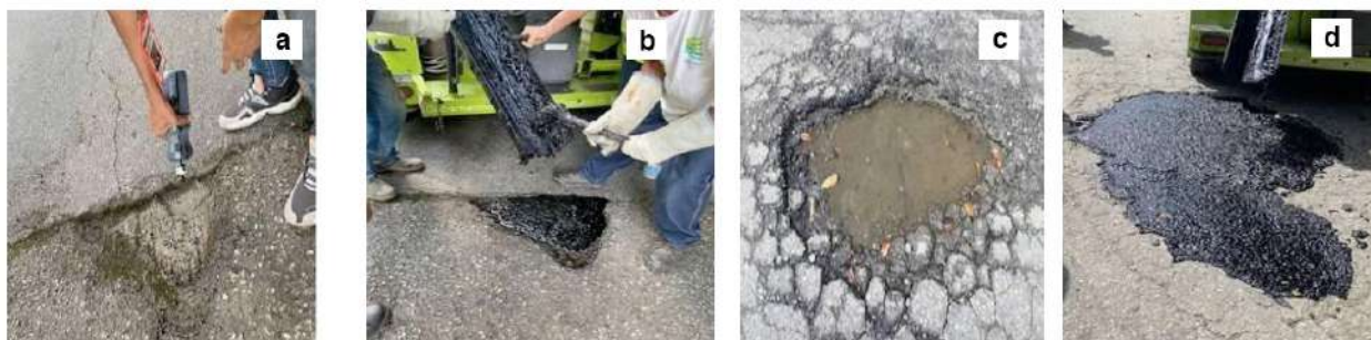
Figura 4. Aplicación de bacheo en caliente a cuatro fallas en la vialidad interna y externa de PDVSA Intevep utilizando el producto tecnológico ASFEL™ (a y b) y el producto comercial NUVO Elite D (c y d)
